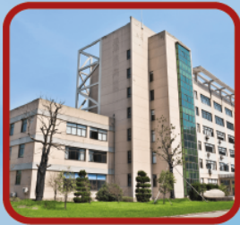
อาคารจัดการพลังงาน
